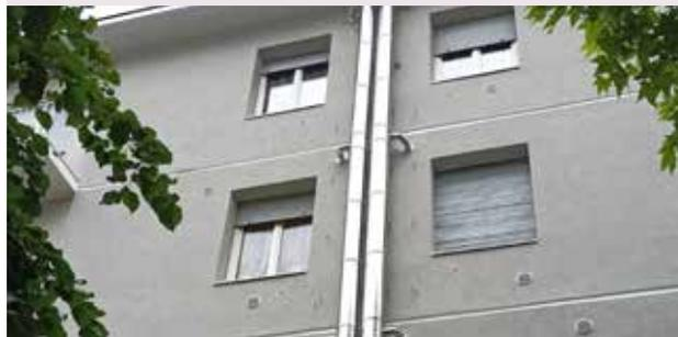
bonus ha permesso la realizzazione di un cappotto termico sulle facciate, la coibentazione del tetto e la sostituzione delle "caldaiette" per il riscaldamento autonomo presenti con nuovi impianti a condensazione dotati di una nuova canna fumaria dedicata.
